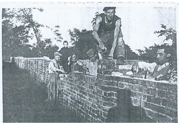
Budowa pierwszego kościoła
